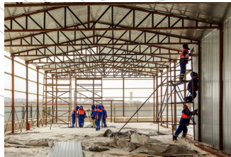
Construção de galpões e estruturas metálicas.
