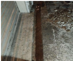
Instalação de drenos.
